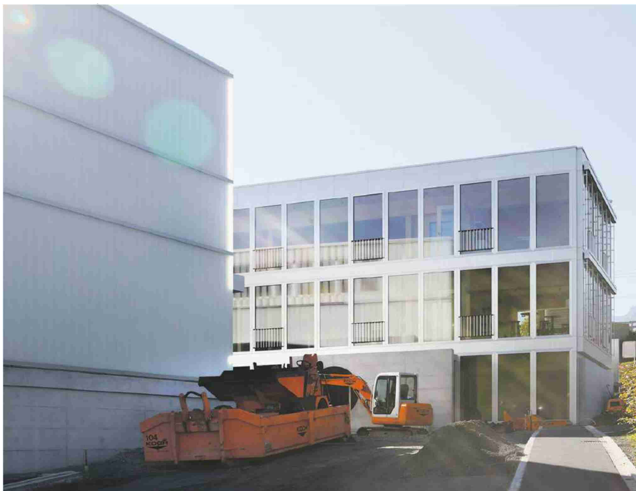
Letzte Arbeiten sind noch im Gang, die Büros sind schon bezogen: GOBA-Neubau in Gontenbad.
